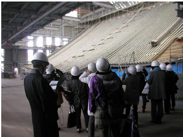
(阿弥陀堂修復見学 貸し出しようヘルメットを着用して見学)
