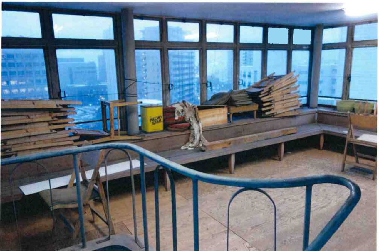
同上 室内 隅柱はRC造になるが立山連峰側だけは鋼管柱になる
