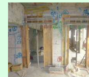
内壁等の補強
