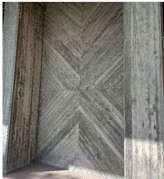
( ↑ 外部の見た目はそのままの補強箇所 )
