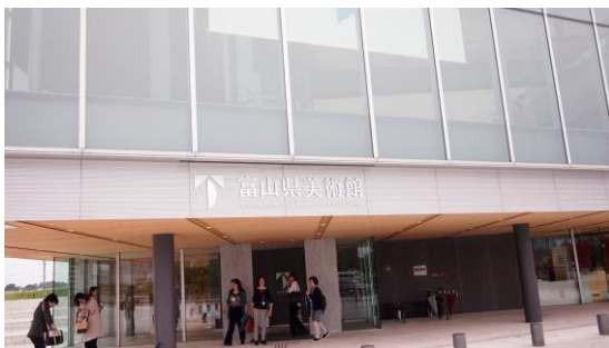
(↑ エントランスまわり)
