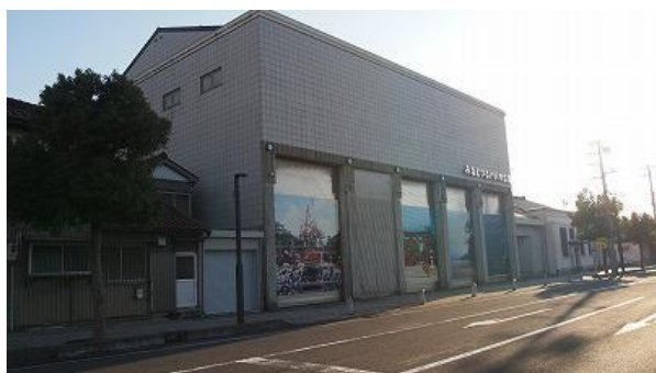
(山車会館裏側、反対側に入り口があります。本物が展示してあるので、お祭りの時出し入れをするため大きな開口になっています。)
