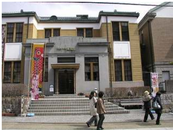
(郡上八幡博覧館正面)
