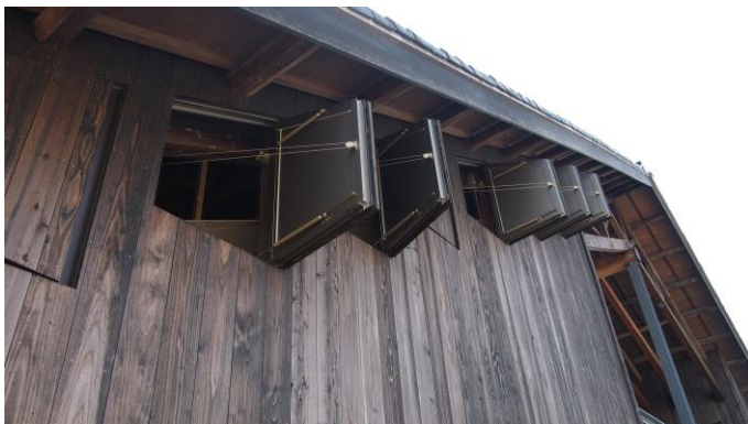
(排煙窓が外壁で隠れているので窓があることが全くわかりませんでした。お願いをして動かしていただきました。)
